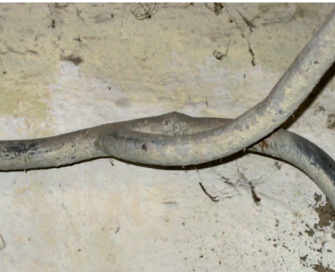
Typische Bleirohr-Installation
